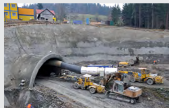
Нагельное крепление и облицовка торкрет-бетоном portalной стенки тоннеля Лалики в Польше
