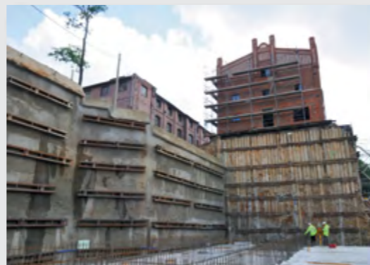
Крепление опорных стенок котлована при строительстве Музея Горного Дела в Польше
