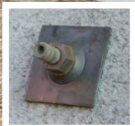
Головная конструкция для торкретбетона
