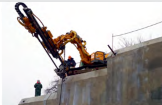
Крепление ж/б - опорной стены анкерными сваями ТИТАН в Сочи, Россия
