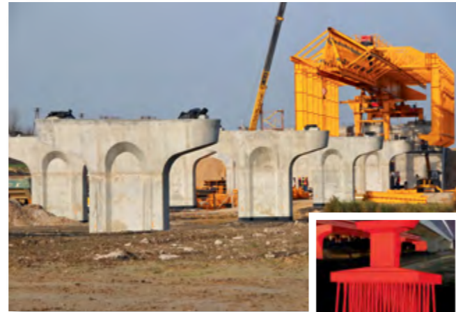
Основание опор эстакады в слабых грунтах на группах из микросвай ТИТАН, скоростная дорога S 7, Польша
