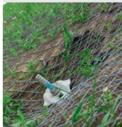
Нагельное крепление и облицовка торкрет-бетоном portalной стенки тоннеля Лалики в Польше
