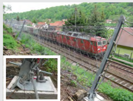
Стабилизация склона вдоль ж/д линии Нюрнберг - Регенсбург нагельным способом, Германия
