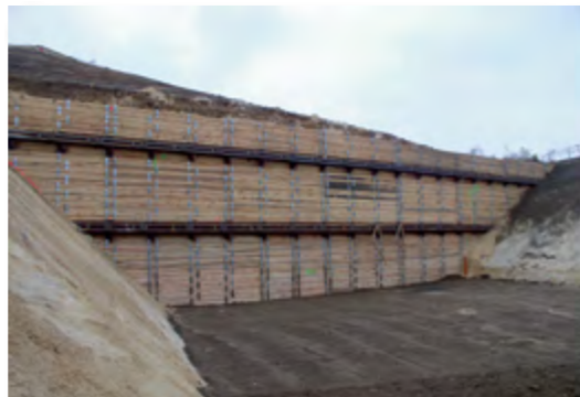
Анкерование „Берлинской стены“ и крепление досок клиновыми замками ТИТАН. Развязка с железнодорожным мостом, Бланкенбург, Германия
