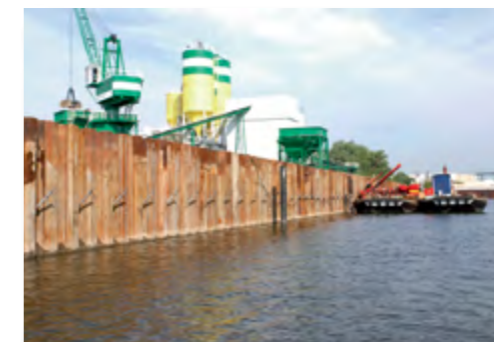
Строительство шпунтового ограждения и установка анкеров ТИТАН с понтона, г. Тиль, Нидерланды
