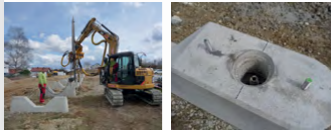
Фундаменты для солнечных коллекторов - навесов для автостоянок. Ж/б-ростверк крепится анкерными сваями ТИТАН, Пассау, Германия
