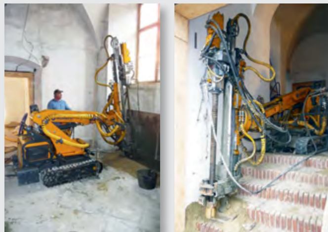
Реконструкция фундаментов исторического здания церкви Святого Игнатия сваями ТИТАН 52/26 и 73/53, Ландсхут, Германия
