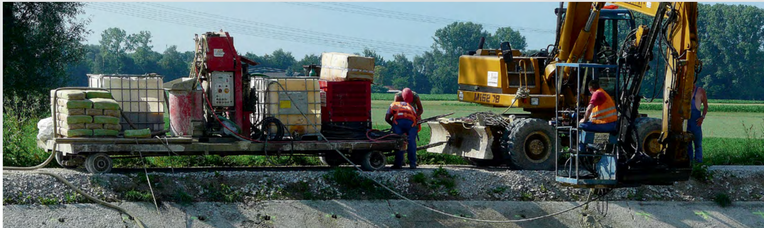
Типичная стройплощадка: экскаватор с навесной мачтой и насосная станция с расходными материалами на прицепе.
