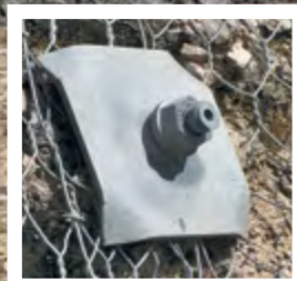
Головная конструкция для крепления металлической сетки
