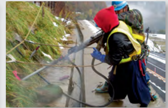
Ручные пневматические перфораторы для бурения малых типоразмеров от ТИТАН 30/16 до ТИТАН 40/16
