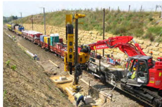
Свайные фундаменты ТИТАН 40/16 под новые мачты электроснабжения железнодорожных линий в Бельгии
