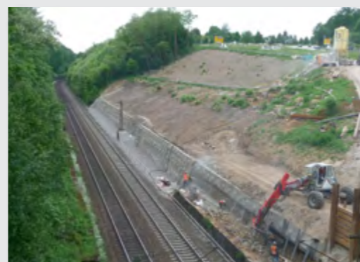
Стабилизация склона вдоль ж/д линии Нюрнберг - Регенсбург нагельным способом, Германия
