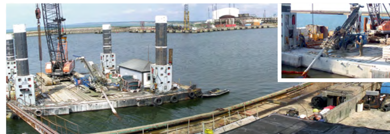
Укрепление существующей конструкции и последовательное анкерование нового трубошпунтового ограждения анкерными сваями ТИТАН 103/43, длиной до 60 м, на глубине 7 м под водой в порту г. Вентспилса, Латвия
